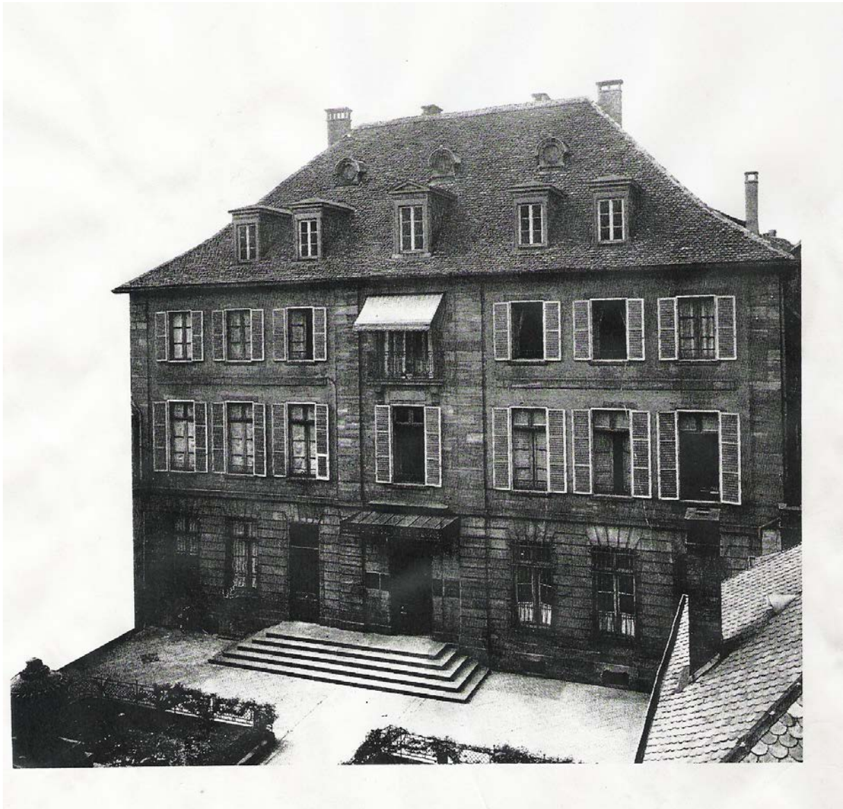
Hôtel Livio, siège de la Sogénal à Strasbourg ( La Sogénal, Livre du Centenaire, 1881-1981 , Strasbourg, Sogénal, 1981)
