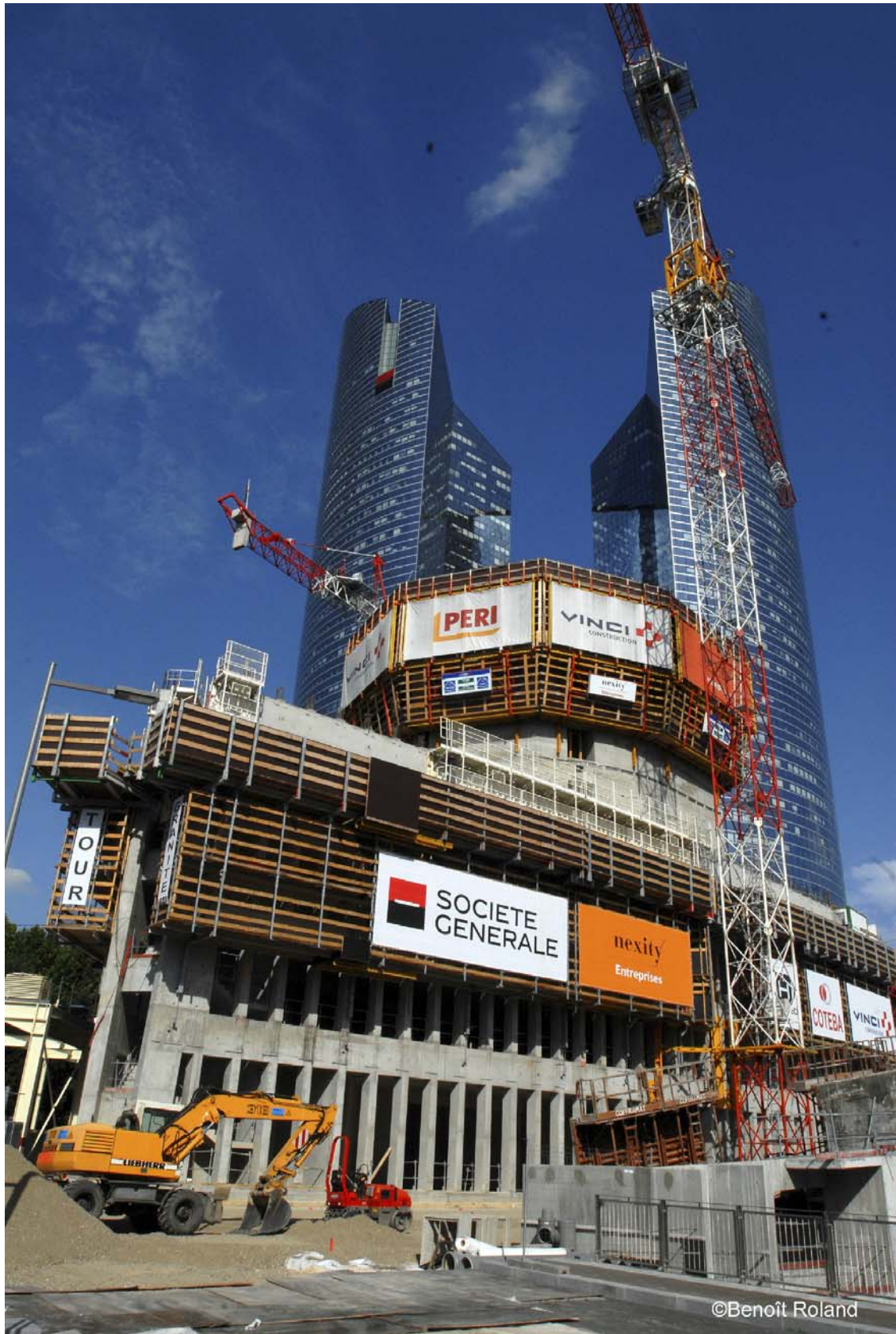
Démarrage des façades, bd des Bouvets.
