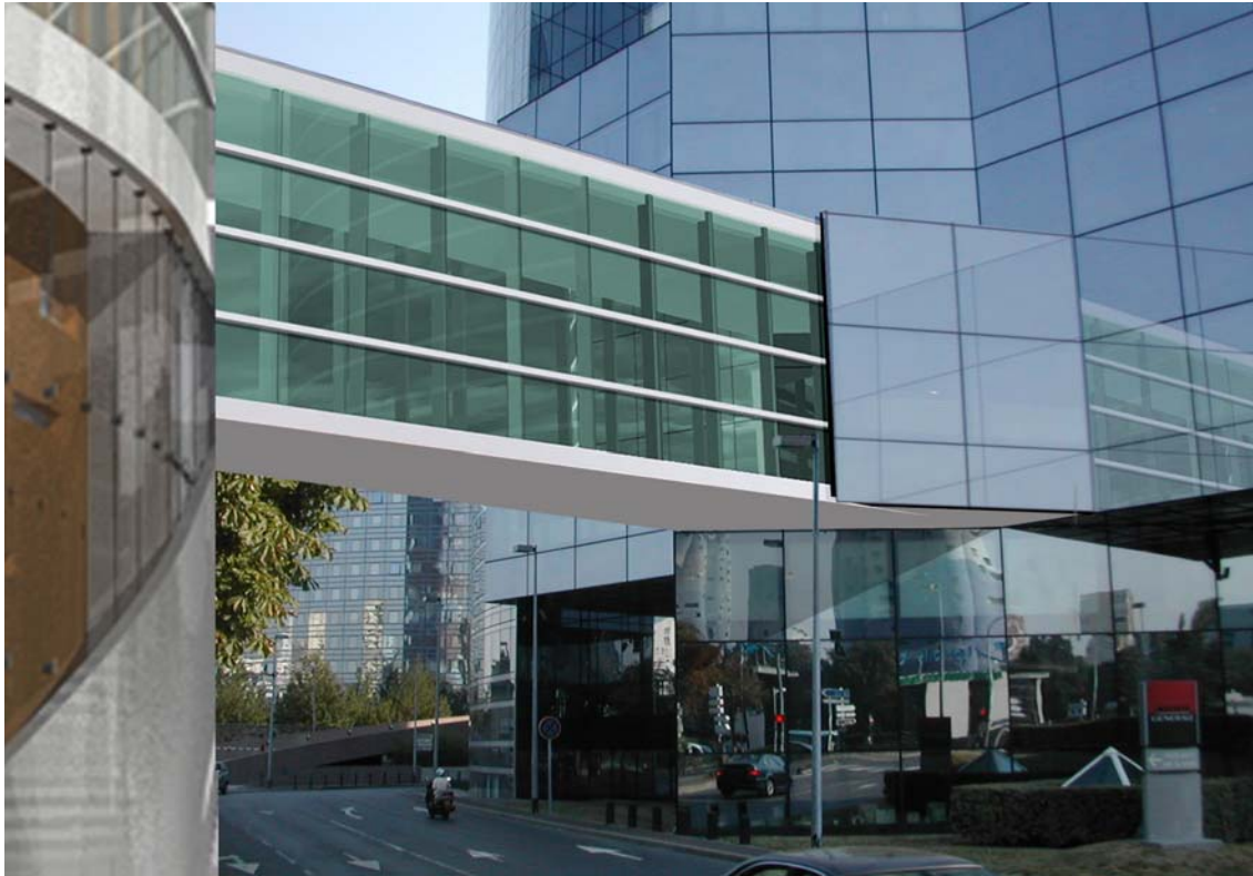
Passerelle privée liant la tour Société Générale à la tour Granite (Atelier C. de Portzamparc).
